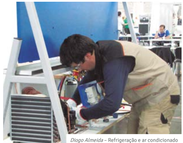
Diogo Almeida - Refrigeração e ar condicionado
